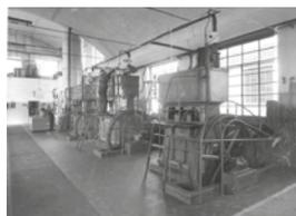
Viene installato il primo impianto di frazionamento dell'aria per la produzione di ossigeno gassoso. I prodotti distribuiti in bombole sono ossigeno da frazionamento, idrogeno da elettrolisi e acetilene da carburo di calcio
